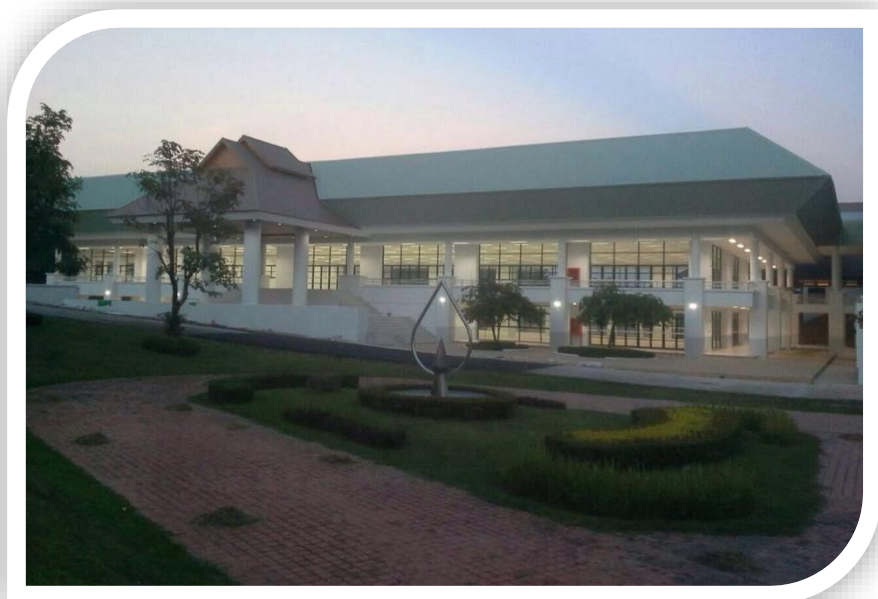
โครงการก่อสร้างอาคารหอประชุมอเนกประสงค์
