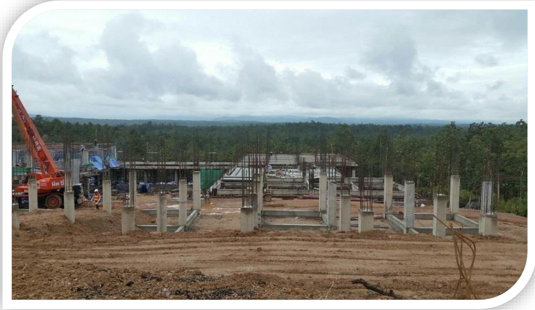
โครงการก่อสร้างกลุ่มอาคารอำนวยการและบริหารกลาง มหาวิทยาลัยราชภัฏเชียงใหม่
